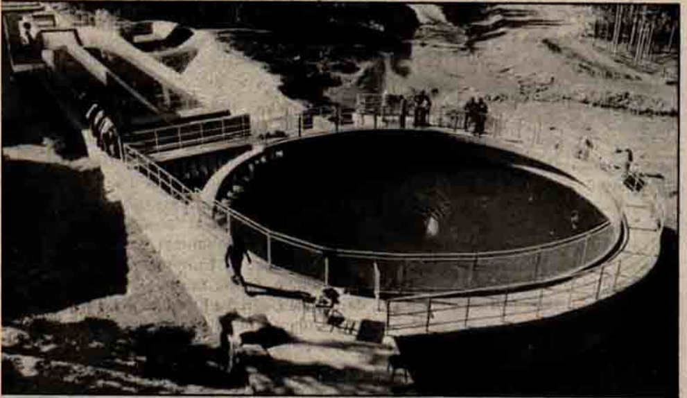
Resim 5— Dairesel Çöktürme havuzu (Sızır hidroelektrik tesisleri)
